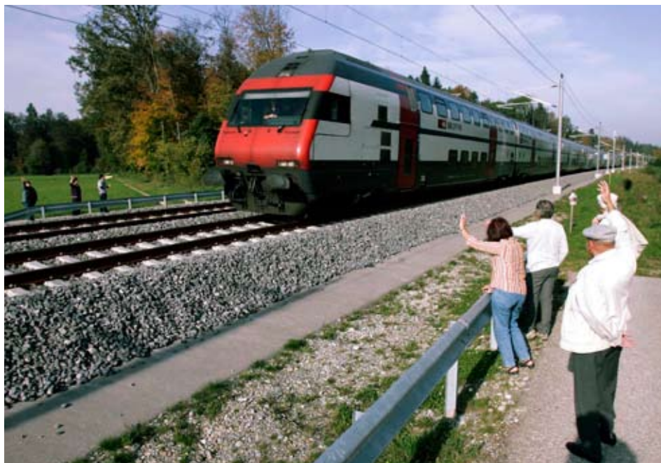
Die Untersuchungsergebnisse zeigen, dass Investitionen in die Verkehrsinfrastruktur einen positiven Wachstumseffekt haben, wenn sie zu einer Reduktion der Reisezeiten führen. Im Bild: Die Neubaustrecke Mattstetten-Rothrist der Bahn 2000.
