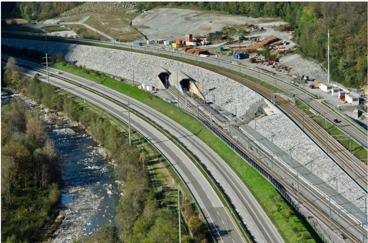
Photo : © AlpTransit Gotthard AG
